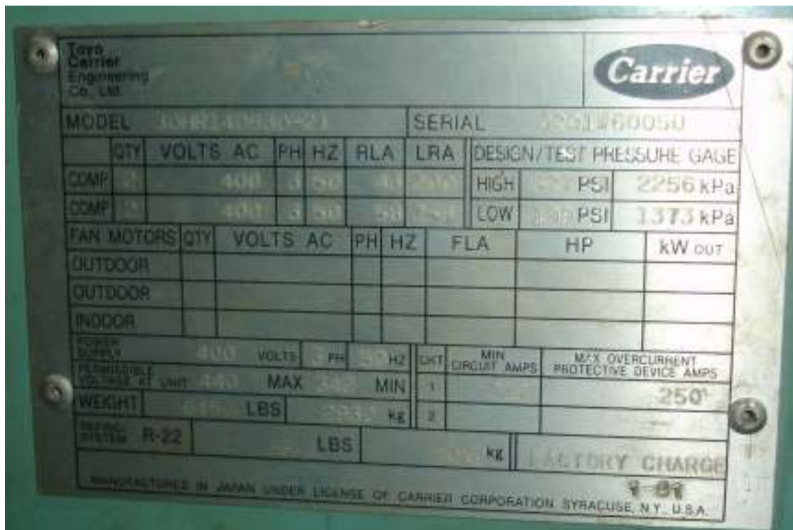
Φωτ 3: Στοιχεία υπάρχοντος ψυκτικού συγκροτήματος Carrier
