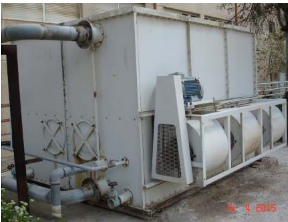
Φωτ 1-2: Υπάρχων πύργος ψύξης
