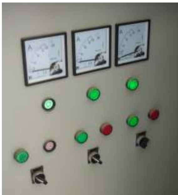
Φωτ. 5: Υπάρχων ηλεκτρικός πίνακας
