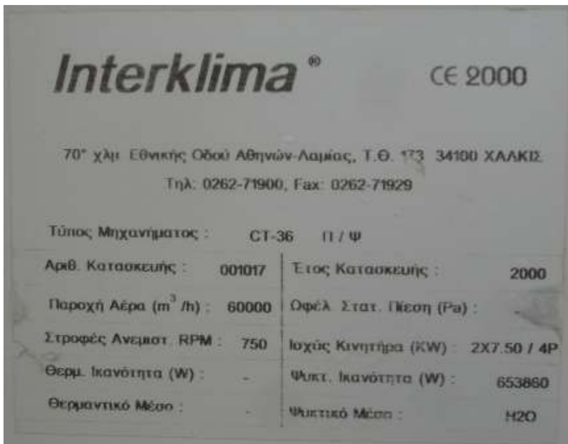
Φωτ 3: Στοιχεία υπάρχοντος ψυκτικού συγκροτήματος Carrier
