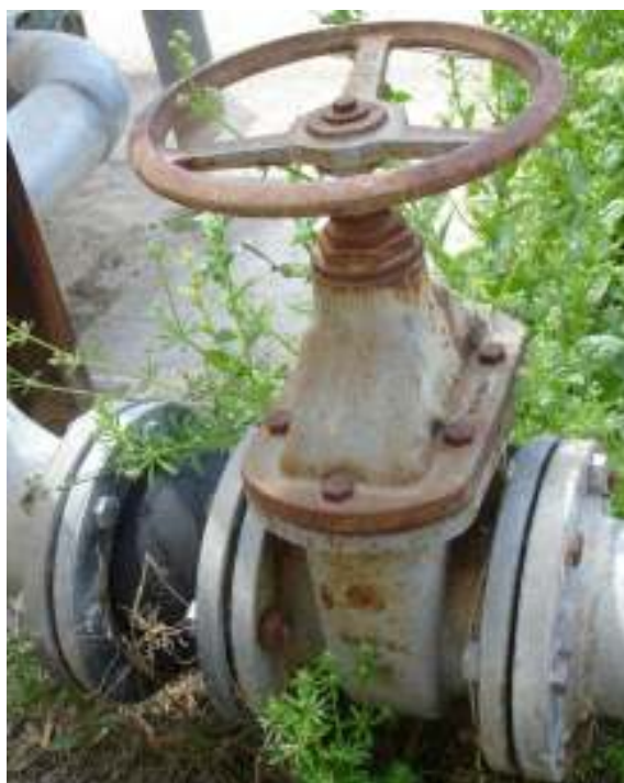
Φωτ. 6: Υπάρχουσες βάνες αποκοπής και διαστολικοί σύνδεσμοι
