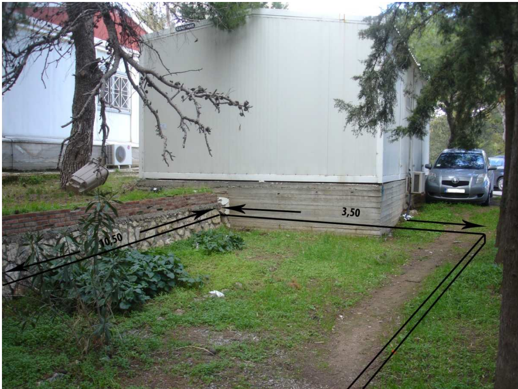
Φωτογραφία 2: Χώρος τοποθέτησης βάσης και δεξαμενών
