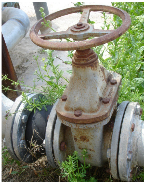
Φωτ. 6: Υπάρχουσες βάνες αποκοπής και διαστολικοί σύνδεσμοι
